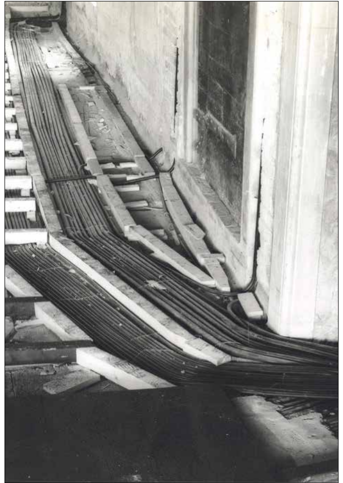
Realizzazione impianti - anni Settanta del Novecento
