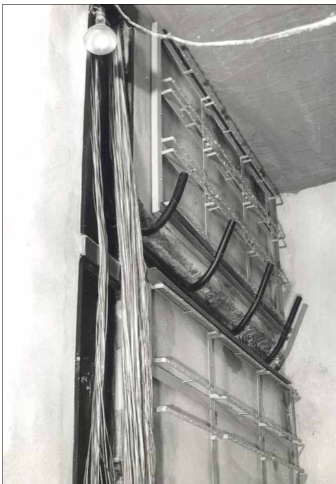
Realizzazione impianti - anni Settanta del Novecento
