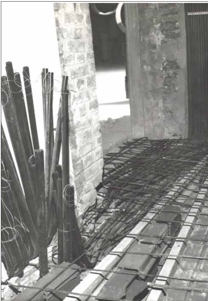
Realizzazione impianti - anni Settanta del Novecento
