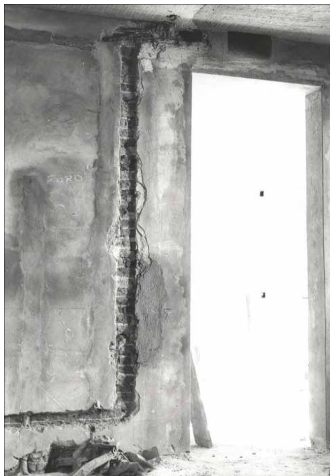
Realizzazione impianti - anni Settanta del Novecento
