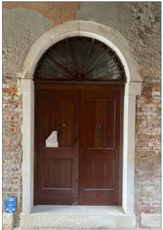
Porta magazzino elettrico piano terra Palazzo Duodo
